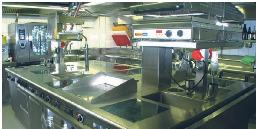
Im Unterbau der Herdanlage wurden 3 Wärmeschrankschubladeblöcke und je eine Cook&Hold-Schublade pro Posten integriert.
