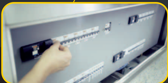
Eingebauter Elektroverteiler – nur eine Zuleitung nötig.
